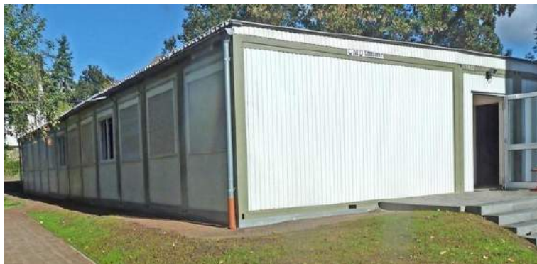
Abbildung 134: derzeitige Interimslösung des Evangelischen Schulzentrums 121
