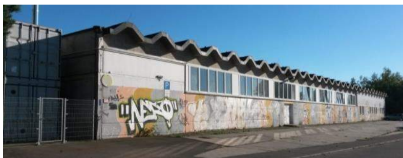
Abbildung 110: heutiger Zustand der ehemaligen NVA-Turnhalle
